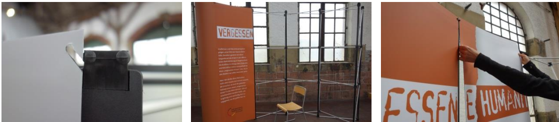
Abbildung 9: Anschließend werden die Magnetwände am Gerüst befestigt. Diese dazu oben in die vorgesehenen Haken einhängen. Der Rest hält magnetisch.
