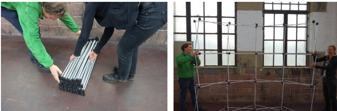
Abbildung 7: Für den Aufbau benötigt es mind. 2 Personen. Beim Abbau das Gerüst einfach wieder zusammenschieben.
