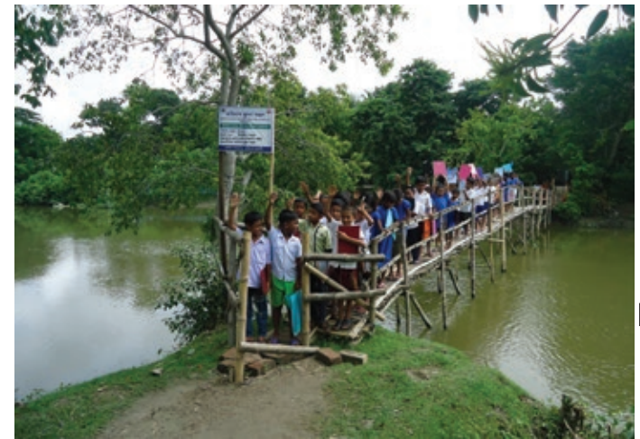
Diese Schulhinder freuen sich über eine neu errichtete Brücke. Zuvor war ihr Schulweg nicht nur beschwerlich, sondern sogar gefährlich.
